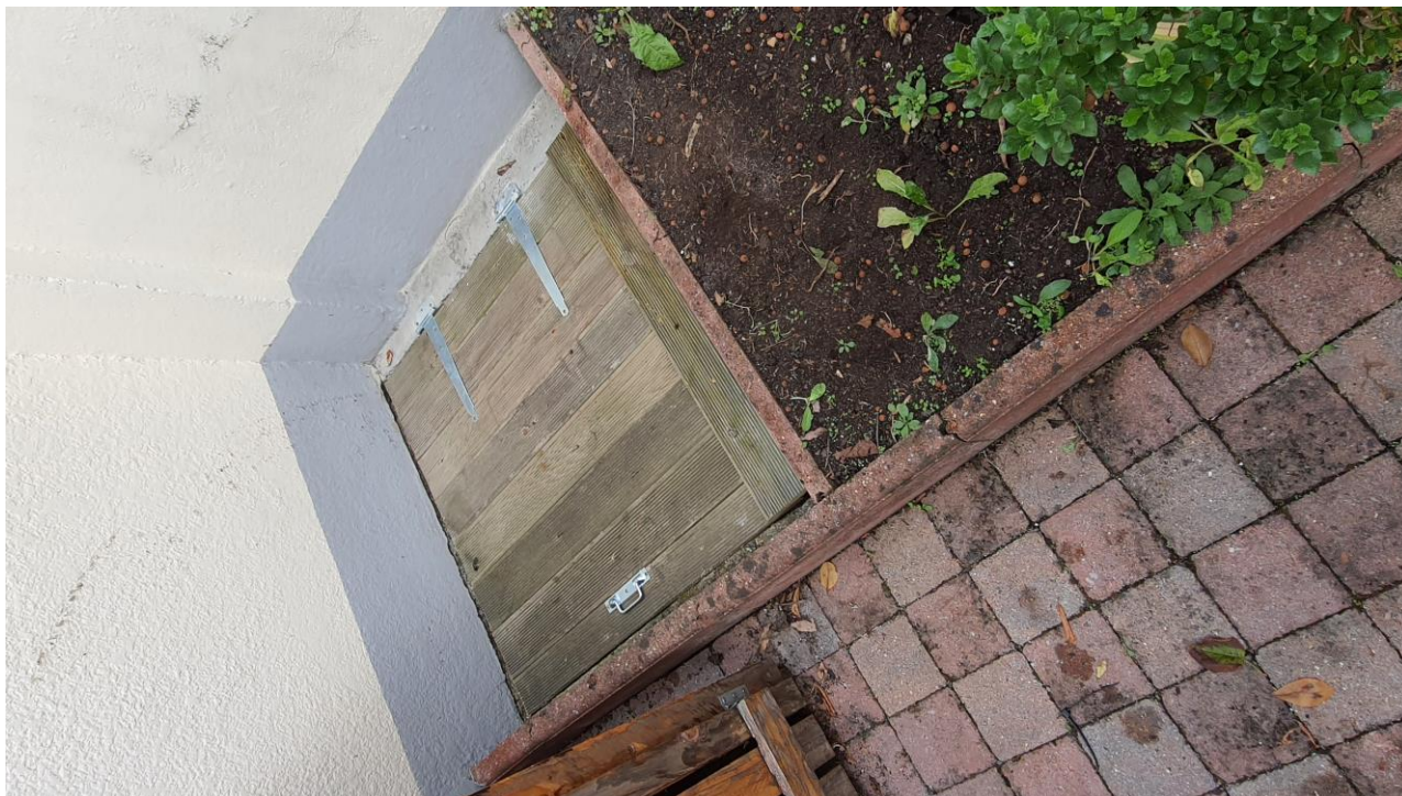
Vue du regard ouvert
